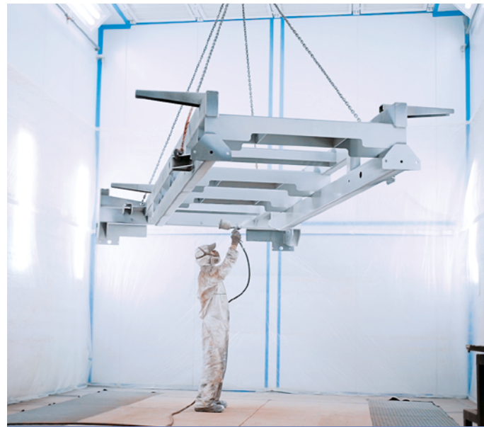
Для крупногабаритных металлоконструкций
