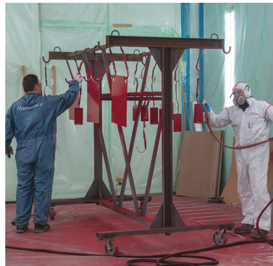
Комплекс подготовки, мойки и окраски поверхности для изделий машиностроительного предприятия, Группа PALFINGER, г. Великие Луки
